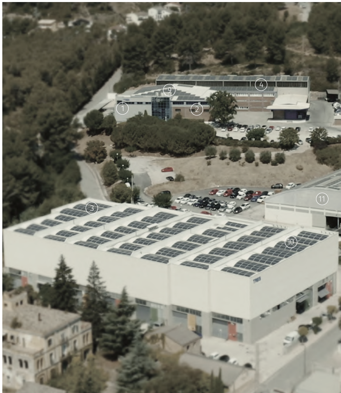
Instalaciones de Tres en Vallirana (Barcelona)
